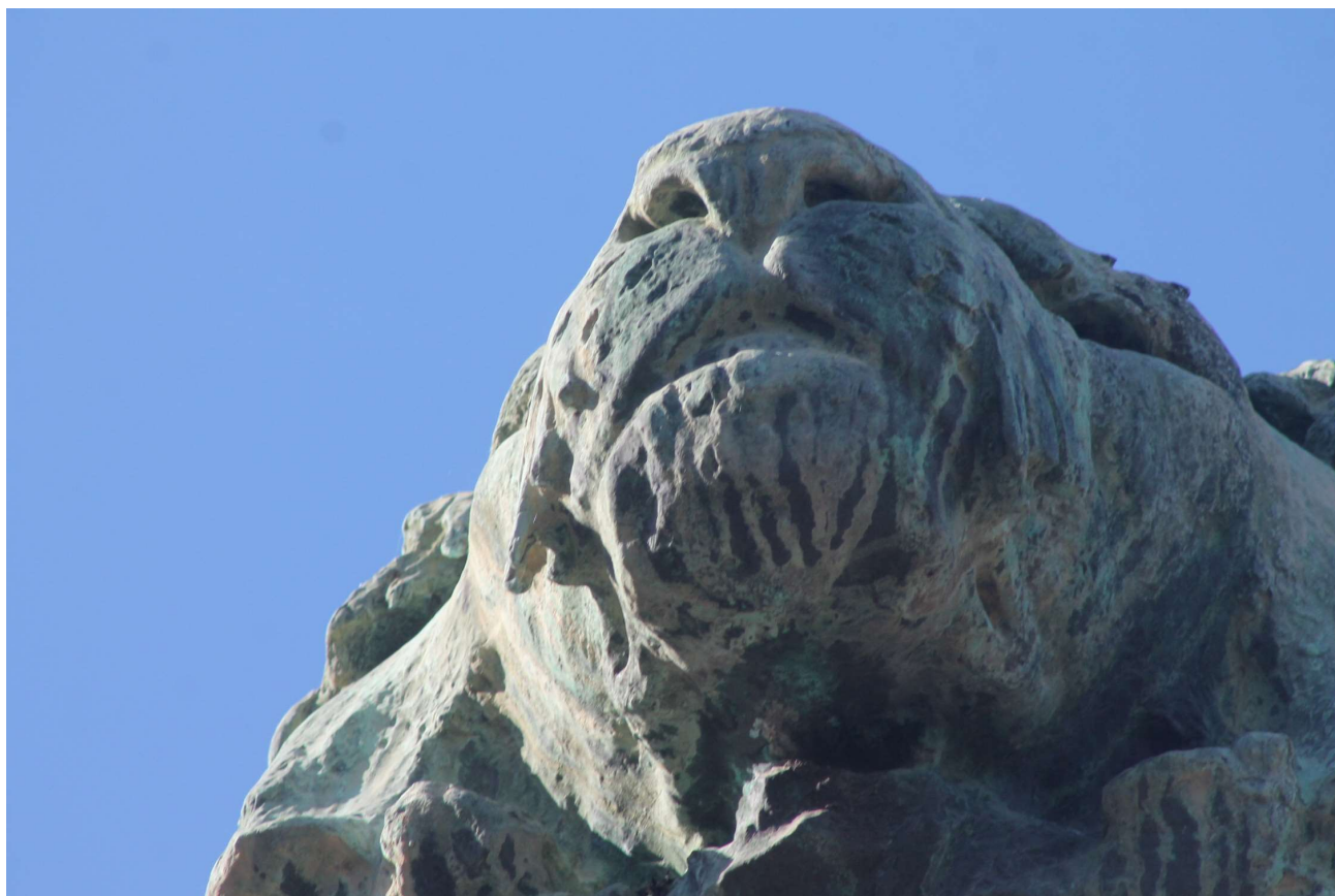
Daños sobre elemento de bronce.
